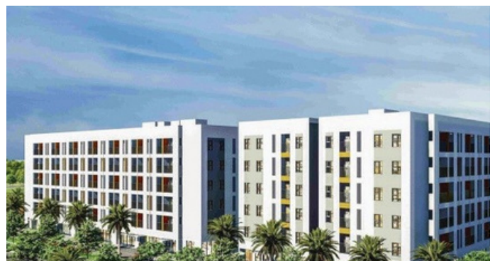
KHU NHÀ Ở QUẬN 9 Sản phẩm: Máy bơm Windy
