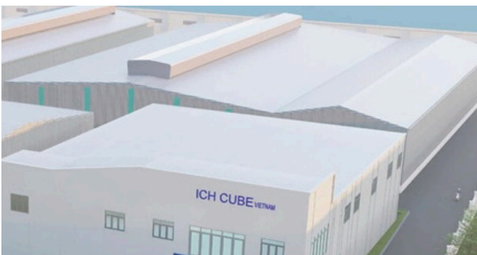
NHÀ MÁY ICH CUBE Sản phẩm : Máy bơm Windy, Tủ điện MBMB
